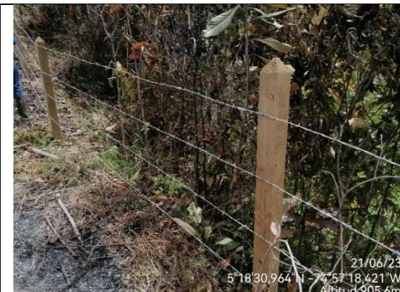
Figura 3.5. Vista de las cuatro cuerdas de alambre de púa en límite del predio El Retorno.
